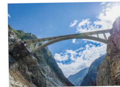
Royal Gorge Bridge, USA
