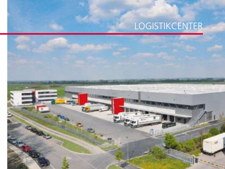
Logistikkomplex GROUP7 mit Bürogebäude
